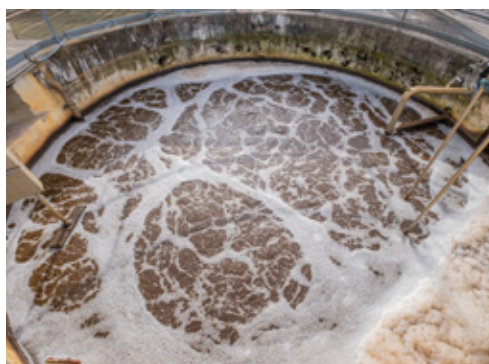
Wird in Zukunft in der St. Galler ARA AU gereinigt: Abwasser in der ARA Mühltofel. Foto: tiz
