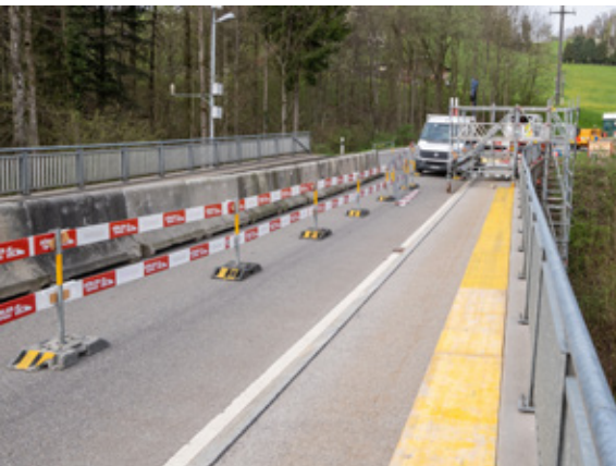
An der Gmündertobelbrücke wird bereits die neue Leitung «aufgehängt». Foto: tiz
