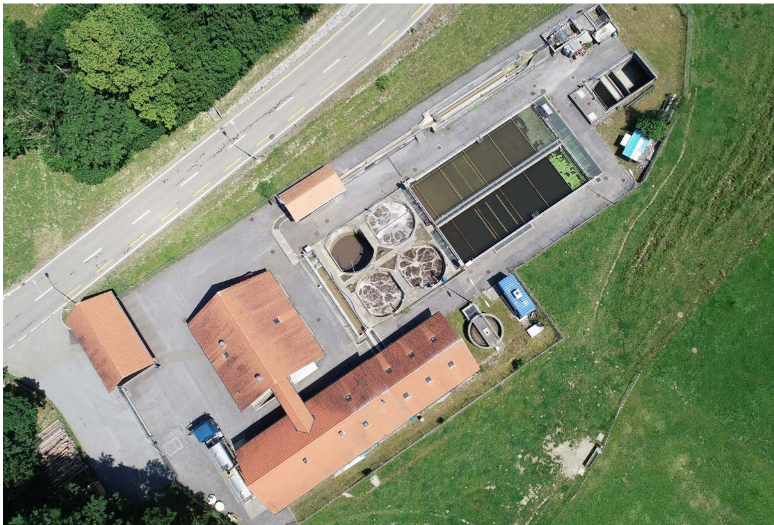
Aus der Luft: die ARA Mühltoibel. Bei einem «Ja» am 7. März wird sie in einigen Jahren zu einem Pumpwerk mit Rückhaltebecken umgebaut. Foto: tiz
