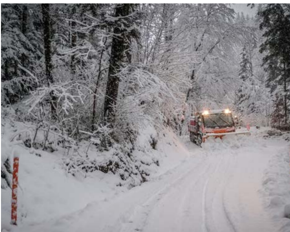
Auch Naturstrassen gehören zur «Hügeltour». Wie hier im Brandtobel. Dabei wird kein Salz verstreut und der Pflug übt weniger Druck auf den Boden aus. So bleiben die «Schneebrücke» und damit der Kiesbelag intakt.
